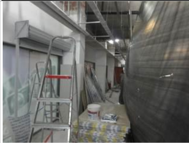
Vista Parcial Interna - Térreo em Obras
