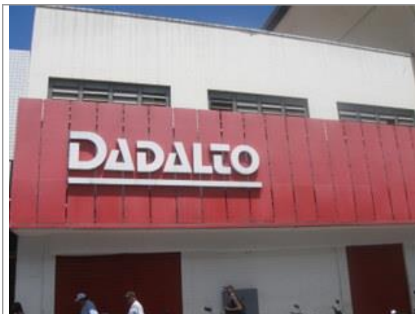
Fachada para a Rua Alexandre Calmon.
