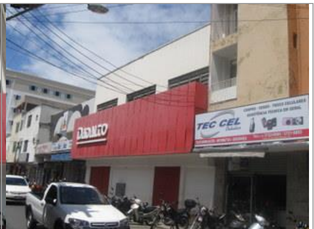
Fachada para a Rua Alexandre Calmon.
