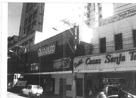
Fachada para a Rua Siqueira Lima.
