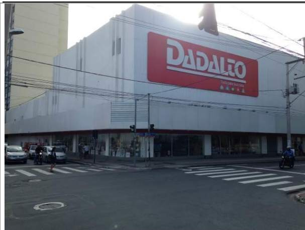
Vista Parcial Externa.
