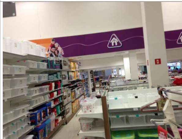
Vista Parcial Interna. - Térreo (Em Reforma)
