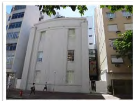
014 - FACHADA DO PRÉDIO INSTITUCIONAL
