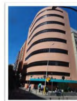
012 - FACHADA DO PRÉDIO PRINCIPAL
